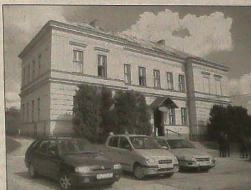
▲ Pierwotnie w tym budynku mieściła się polska szkoła, obecnie jest w nim hotel i restauracja. Fot. KAZIMIERZ SANTARIUS
