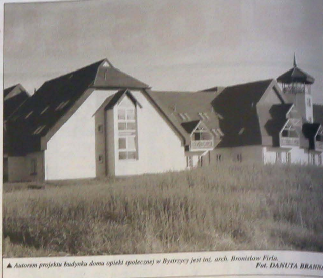
Autorem projektu budynku domu opieki społecznej w Bystrzycy jest inż. arch. Bronisław Firla. Fot. DANUTA BRANNA
