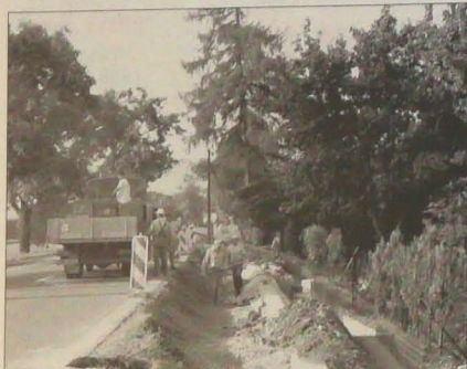
Robotnicy budujący zatokę na przystanku autobusowym Cegielnia w Ropicy mają już połonione rury kanalizacyjne. Fot. DANUTA BRANNA
