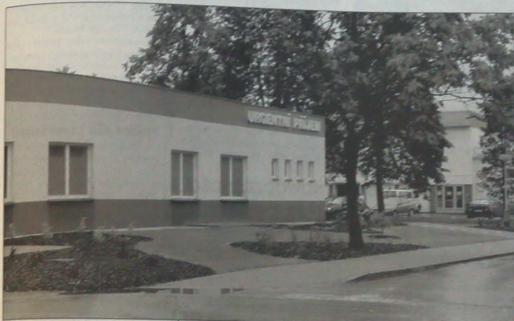
▲ Budowę pawilonu nagłych przyjęć rozpoczęto w październiku ub. roku. Wczoraj oddano go do użytku. Fot. BEATA SCHÖNWALD
