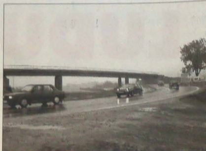
W Żukowie trwa wytyczanie czteropasmowej drogi szybkiego ruchu. W miejscu, gdzie krzyżuje się ona z szosą Cz. Cieszyń - Frydek-Mistek, bezkolizyjny ruch zapewni nowy most.
