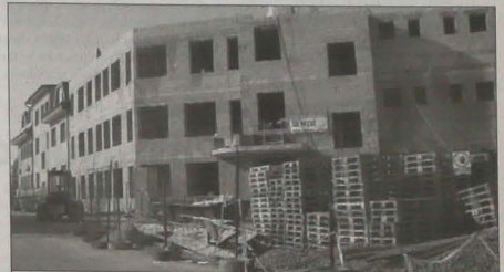
▲ Wszystkich 197 pracowników trzynieckiego urzędu miejskiego znajdzie w przyszłym roku lokum w jednym gmachu. Pracownicy spółki akcyjnej Beskidzka Budowlana, którzy wykonują przybudówkę ratusza, mają już gotową bryłę obiektu i niebawem pokryją ją dachem. Obecnie część biur mieści się w hotelu „Steel” i w byłym hotelu „Sławan”. Fot. DANUTA BRANNA
