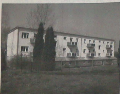
Ten budynek na karwińskich Granicach, w którym mieściło się kiedyś przedszkole, ostanio zaadaptowano na dom pomocy społecznej. W maju zaczęła się doń wprowadzać pierwsza lokatorka.
