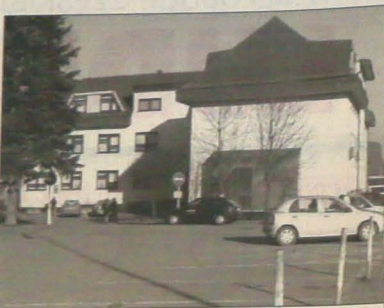
Niebawem rozpoczną się prace przy poszerzeniu trójmiejskiego ratusza. Decyzja o wybudowaniu nowego skrzydła tego budynku została podjęta w związku z przeniesieniem do urzędu niektórych byłych agend powiatowych...
