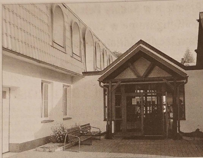
Nowe kuchnie, podłogi, okna, szerokie drzwi i nowoczesne wyposażenie pokoi – to m.in. efekt trwającej cztery miesiące przebudowy i rozbudowy Domu Seniora w Pietwałdzku. Rekonstrukcja prawie 30-letniego obiektu zamknęła się kwotą 12 mln koron. Kwotę 11 mln wydał Urząd Wojewódzki. Obecnie spokojną starość w pensjonacie tym może spędzać 175 klientów. Na zdjęciu – wejście główne do pietwałdzkiego Domu Seniora. (mro) Fot. archiwum województwa
