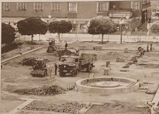
Na czeskokleszyńskim rynku prawie gotowe są już fundamenty pod przyszłą fontannę.
