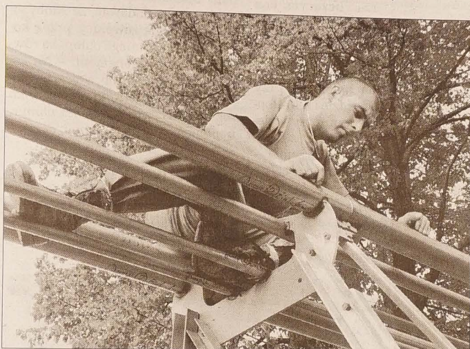
Pavel Marszalek z mosteckiej firmy Usługi Techniczne montuje podpórki toru, który w tym miejscu prowadzi kilka metrów ponad terenem.
