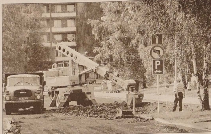
Rekonstrukcję rozpoczęto od usunięcia starej nawierzchni.
