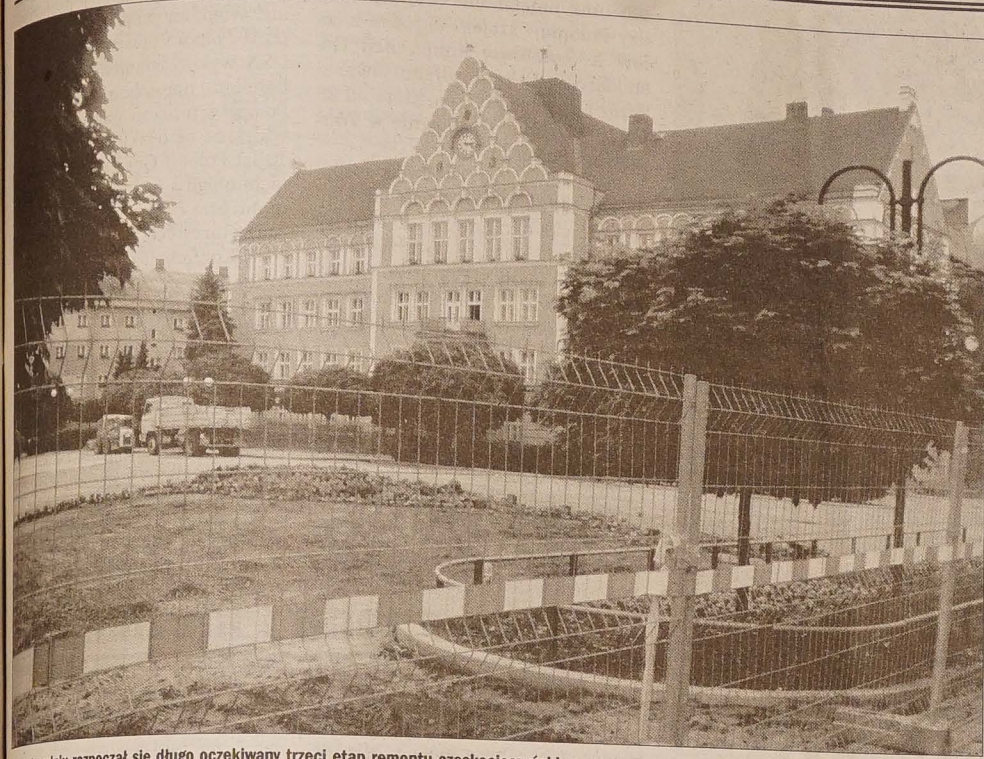
W tym tygodniu rozpoczął się długo oczekiwany trzeci etap remontu czeskojęzyckiego rynku w Lesznej Dolnej. W wtorek pracownicy firmy „Tchas” zaczęli zrywać z płyty rynku bruk. Nowe nawierzchnię tworzyć będą kolorowe kostki brukowe i szare pasy z granitu. Na środku rynku stanie ponadto fontanna. Fot. JACEK SIKORA
