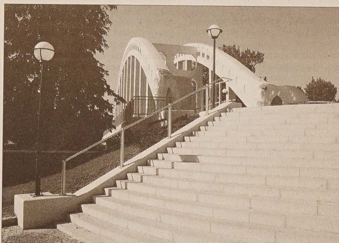
Zabytek techniki – darkowski żelbetowy most przez Olzę Iłni nowością.
