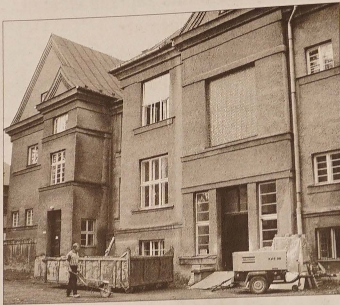
Początek remontu budynku szkoły w Jablonkowie im. H. Sienkiewicza. Fot. DANUTA BRANNA
