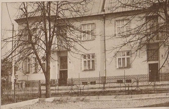
W ub. roku sibska PSP przeniosła się do nowych pomieszczeń. W opuszczonym budynku mieści się obecnie Dom Seniora. Fot. archiwum Sileskiej Humanisty
