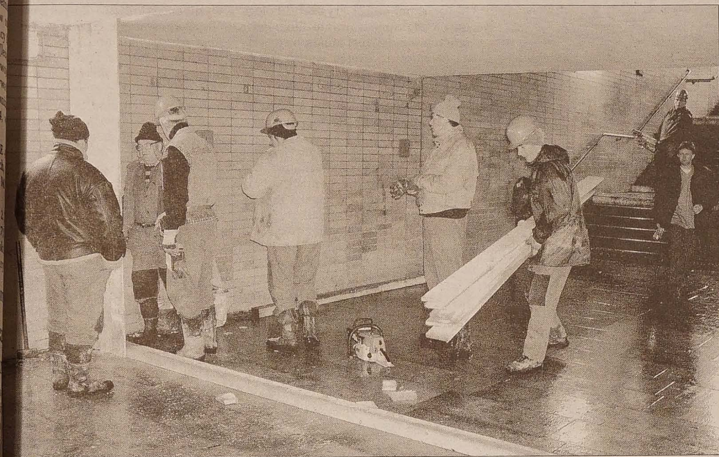
Przeście podziemne na dworcu w Czeskim Cieszynie było dotąd pułapką dla obywateli niepełnosprawnych. W 1997 r. wybudowano przeście bezbarierowe od strony BILLI, po drugiej stronie były jednak tylko schody. O uzyskanie dotacji państwowej na budowę drugiej części prześcia władze miasta zabiegały kilka lat. Obecnie trwa budowa zejścia bezbarierowego również od strony dworca i poczty. Skrzyżowanie między dworcem i hotelem PIAST zamknięto na początku bm. Pod koniec tygodnia ruszą prace w samym przeście, które będzie zamknięte do zakończenia prac. Przechodnie będą mogli korzystać z prześcia Demeloch. Podróżujący natomiast będą przechodzili na perony przez halę dworcową. Na pocztę od następnego tygodnia będzie można wchodzić z drugiej strony - od budynku Kolei Czeskich, w którym przeprowadzana jest odprawa celna. Fot. DANUTA BRANNA
