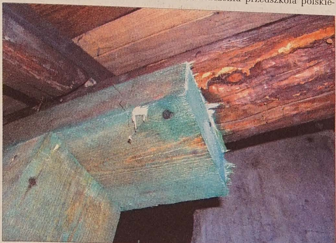
Na przedszkolnym strychu oprócz starych belek są i nowe, efekt przeprowadzonych prac rekonstrukcyjnych podczas wakacji 2004 r. Te nowe są łatwo zauważalne – mają niebieskawy odcień...
