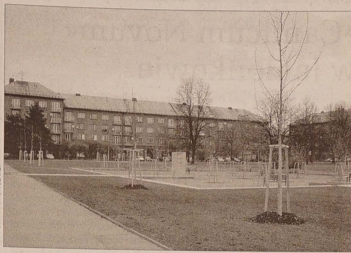
W przewidzianym terminie (30. 4. 2005), a nawet z wyprzedzeniem, zakończone zostaną prace związane z rekonstrukcją Pomnika Wyzwolenia i przebudową okalającego go skweru na park w Karwinie Nowym Mieście. Gotowy jest już postument, na którym stanie pierwotna rzeźba „Wojownika”, posadzono wiele nowych drzew, wytyczono nowe chodniki, zainstalowano oświetlenie, montowane są ławeczki. Brakują tylko napisy, w tym i polski - „Na pamiątkę ofiarom okupacji hitlerowskiej i wojny miasta Karwiny 1939-1945”. Na zdjęciu ogólny widok całego skweru z pustym na razie postumentem.
