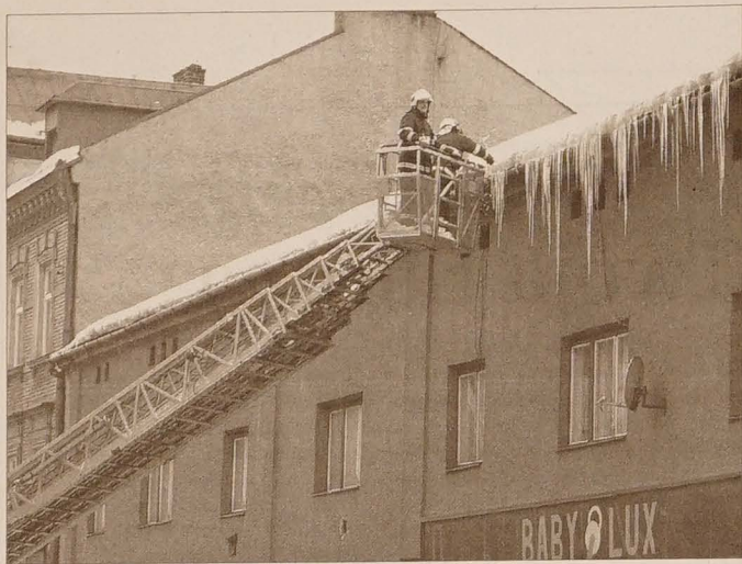
W ciągu dnia słońce, nocą mróz - taka pogoda sprzyja tworzeniu sopli. Do tego dochodzą mało uszczelnione dachy i poddasza oraz nieprzepustne rynny. W końcowym efekcie do usunięcia ogromnych sopli trzeba wzywać strażaków, jak na naszym zdjęciu z ul. Główniej w Cz. Cieszynie. Przypominamy, że to właściciele budynków są odpowiedzialni za sople na ich dachach i szkody, które mogą one spowodować. Fot. DANUTA BRANNA
