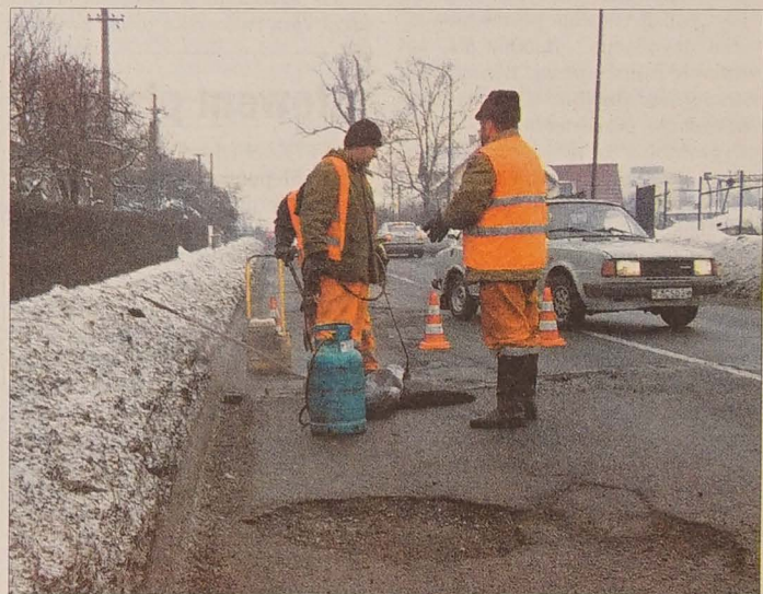
Po trwających miesiąc zimowych opadach i intensywnych zabiegach odśnieżających droga międzydrogowa z Cz. Cieszyna na Słowację przypominać zaczyna durszłak. Na pograniczu Jabłonkowa i Nawsia już we wtorek drogowcy zabrali się do łatania największych dziur, ale ostatnie opady uniemożliwiły kontynuowanie remontu. Drogowcy twierdzą, że po zimie zawsze pojawiają się dziury i trzeba się z tym pogodzić... Jeśli tak, to dlaczego wybudowana dzięki wsparciu UE nowa droga z Cz. Cieszyna do Trzyńca przez Baliny przetrwała już drugą zimę bez uszczerbku? Fot. DANUTA BRANNA
