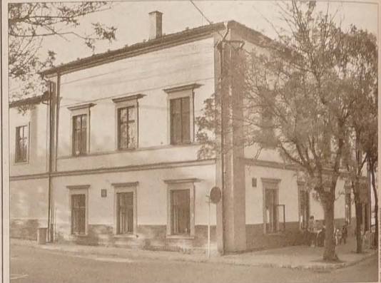
Obiekt, w którym kiedyś mieściła się szkoła, a potem polska sztugarówka w Dąbrowie.
