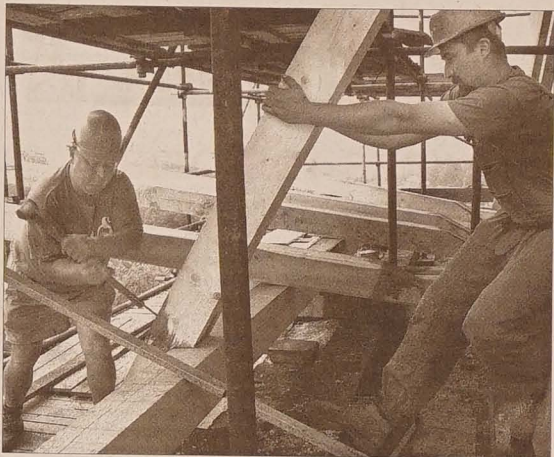
Cieśle mocują kolejną belkę konstrukcji dachowej.
