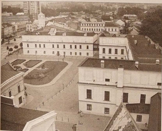
Taki widok na frysztacki rynek rozciąga się z murów wieży kościoła.
