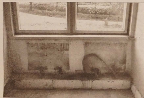
Pod tymi oknami były kiedyś kaloryfery.
