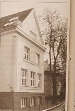
Surmia przed frontem budynku szkolnego
