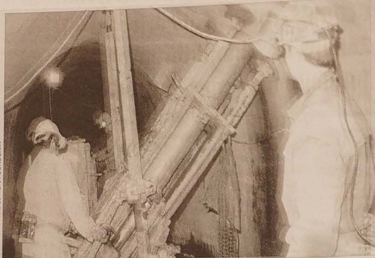
Prace budowlane prowadzone przez spółki TCHAS, Ingstas Ostrawa oraz Subterra przebiegają od stycznia 2003 do stycznia br.
