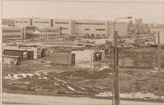
W Specjalnej Strefie Przemysłowej w Hrabowej na skraju Ostrawy przy drodze na Frydek-Mistek czekają na inwestorów tereny.
