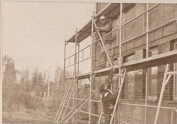
Na budynku biurowym właśnie przebiega remont.
