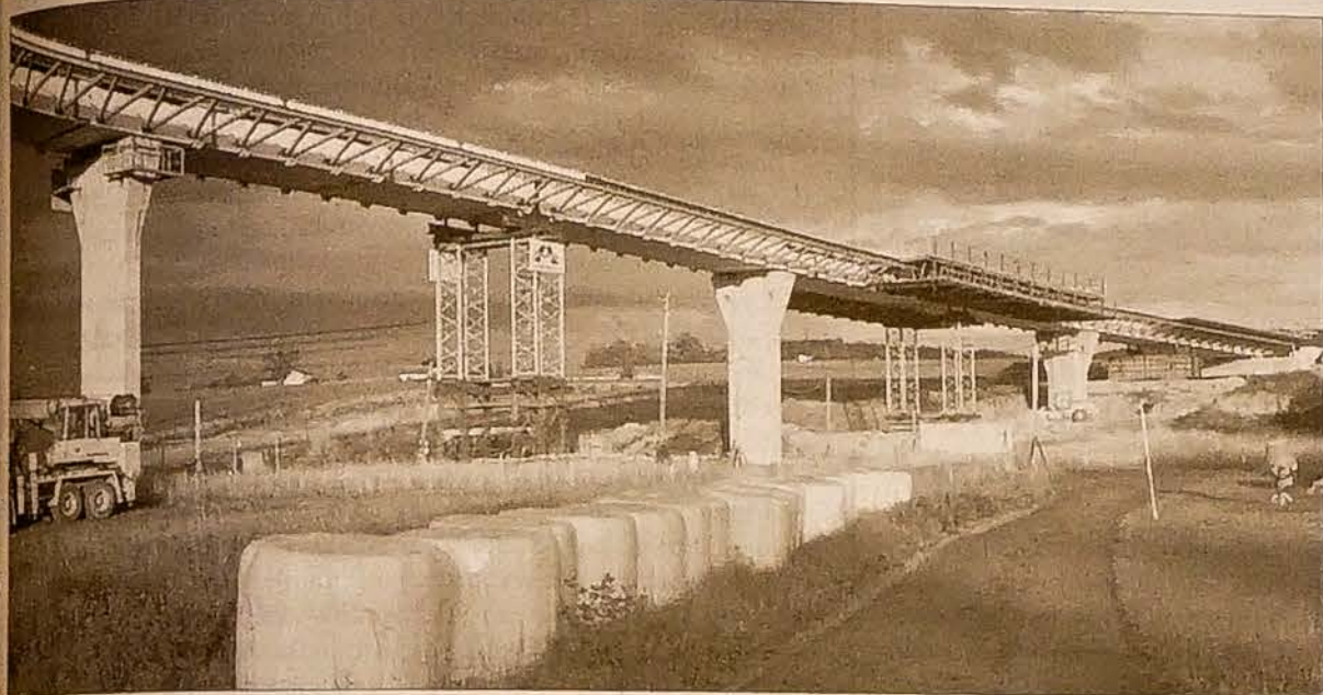
Przejeżdżający przez Boconowice i Łomną mogą podziwiać szybko powstające olbrzymie mosty. Budowana obwodnica Jabłonkowa oddzieli znacznie miasto od samochodów osobowych i TIR-ów. Tych ostatnich na pewno jeszcze przybędzie na drodze w związku z budową zakładu „Hyundai” w Noszowicach.
