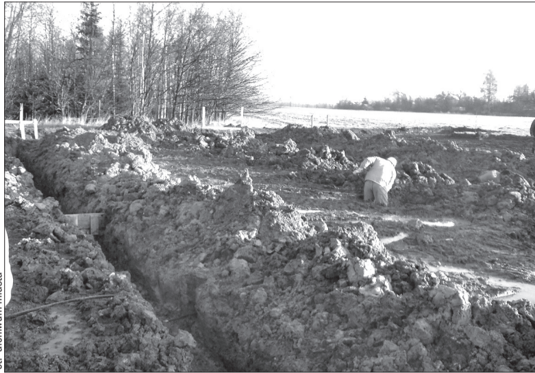
Rozpoczęły się prace na budowie hawierzowskiego schroniska dla psów.
