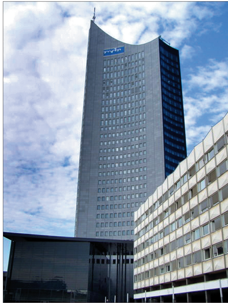
Do niedawna w tym wybudowanym w 1972 r. najwyższym wieżowcu Lipska mieścił się tamtejszy uniwersytet.
