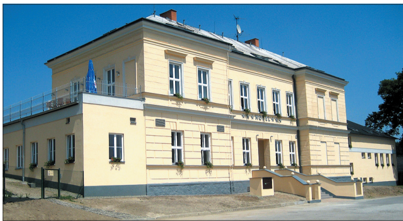
Nowa sylwetka hotelu „Dakol” z dobudowanymi skrzydłami. W prawym znajdują się sauny z basenami oraz nowe pokoje hotelowe, w lewym można zagrać w bowling.
