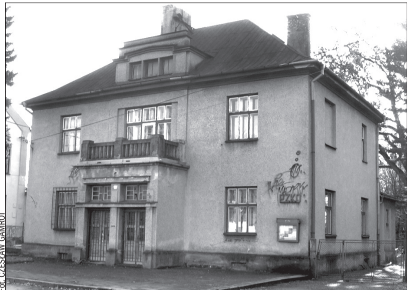
Na parterze byłego Urzędu Gminnego w Darkowie rozgościła się świetlica Miejskiego Koła PZKO. Budowla ta jest usytuowana w sąsiedztwie byłej polskiej szkoły.
