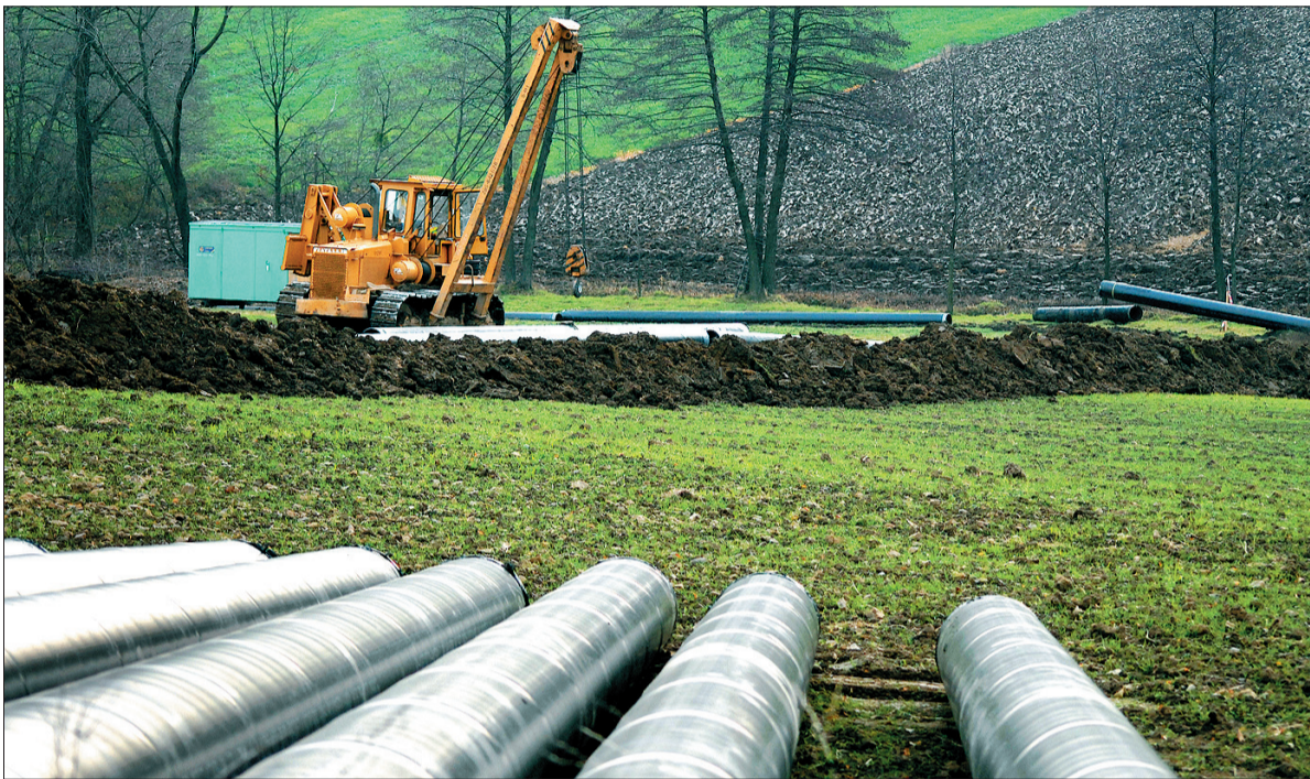
Gaz nowym rurociągiem ma popłynąć 1 stycznia 2011 roku. Po polskiej stronie budowa już ruszyła, po czeskiej ma się rozpocząć w przyszłym roku.
