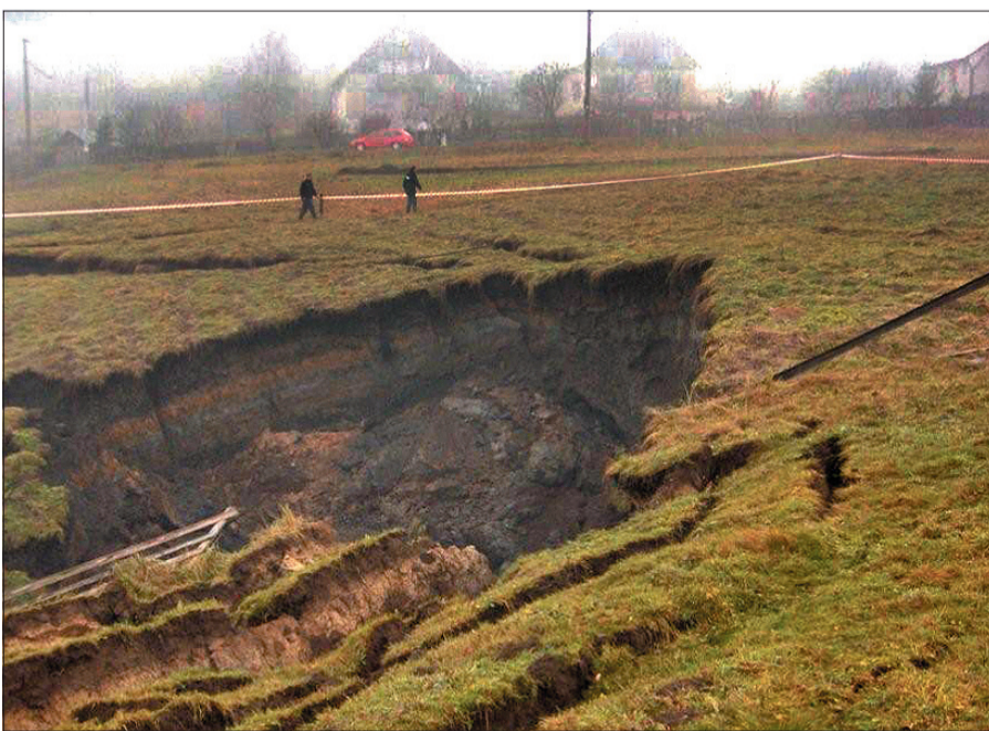
Miejsce katastrofy budowlanej w Mostach koło Jabłonkowa.
