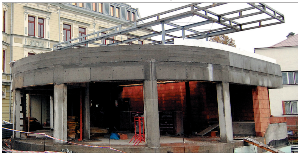
Przy moście Przyjaźni trwa budowa obiektu wielofunkcyjnego nawiązującego do kawiarni Avion.
