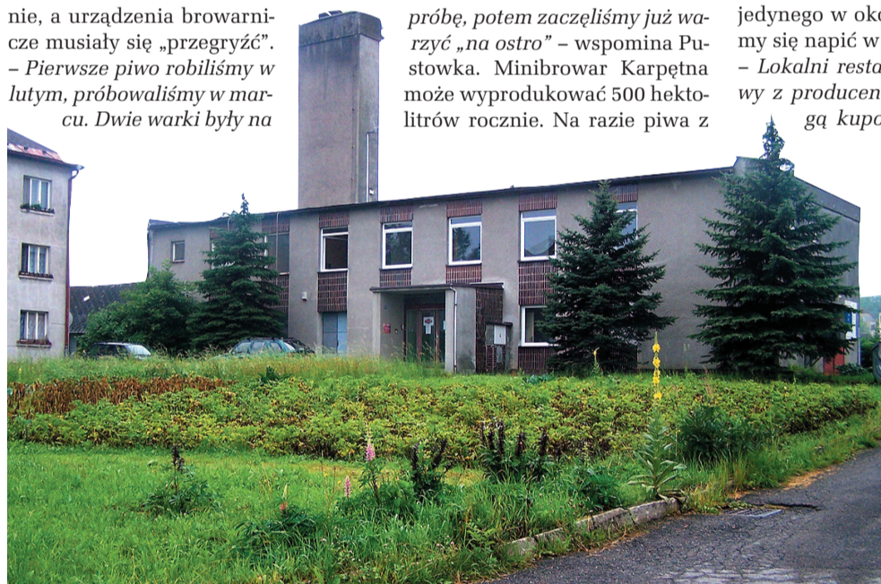
Budynek browaru znajduje się między blokami w Karpętnej, służąc równocześnie jako ich kotłownia.
