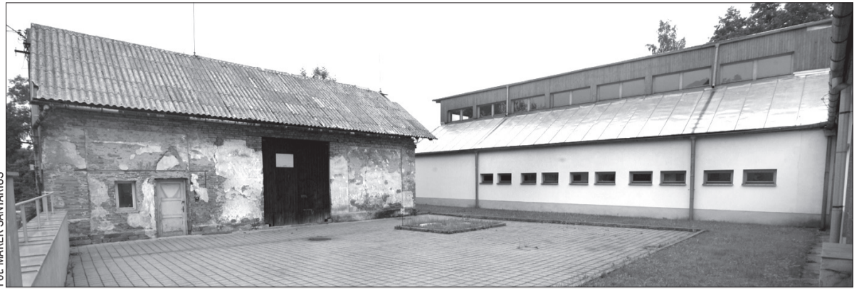
W miejscu starej stodoły, przylegającej do polskiej szkoły w Gnojniku, ma stanąć nowe przedszkole.
