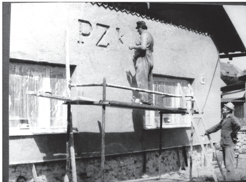
Pezetkaowcy podjęli się remontu starego budynku i zaadaptowania go na dom PZKO.
