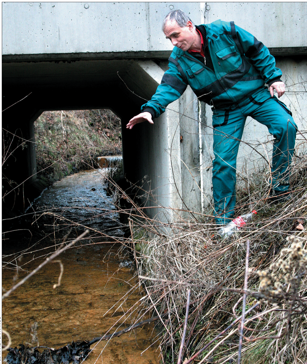
Zastępca wójta Wędryni, Bogusław Raszka, mówi o konieczności podłączenia gminy do kanalizacji. Ścieki zanieczyszczają Wędryniankę, która wpada do Olzy.
