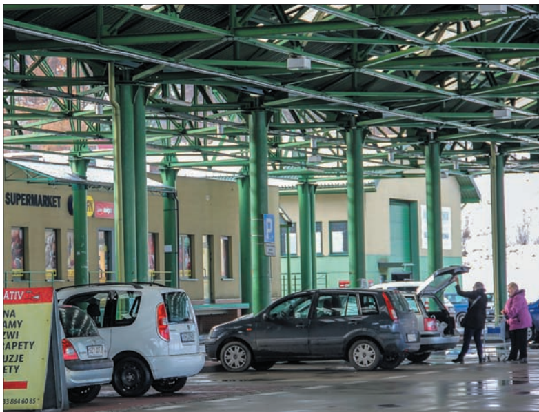
Zadaszone przejście graniczne w Zwardoniu zmieniło się w supermarket.
