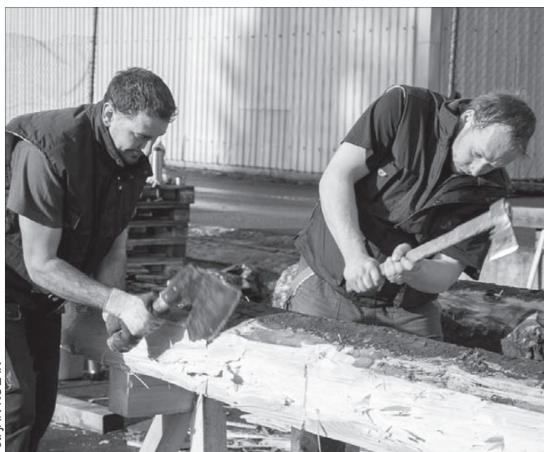
Rzemieślnicy przygotowują belki na budowę.
