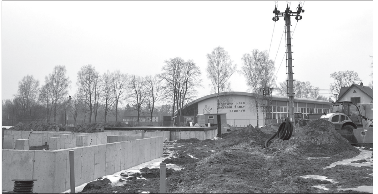
Pomimo trudności finansowych położono fundamenty pod nowe domy dla seniorów.
